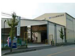
本社サービスセンター 本社倉庫
