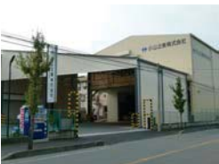
本社サービスセンター 本社倉庫
