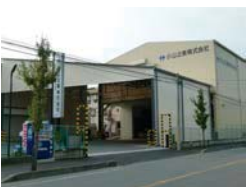
本社サービスセンター 本社倉庫
